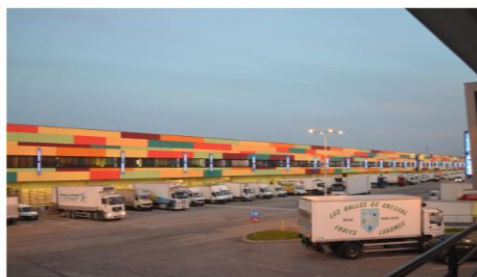
Vue depuis la terrasse de la Cuisine du Marché
